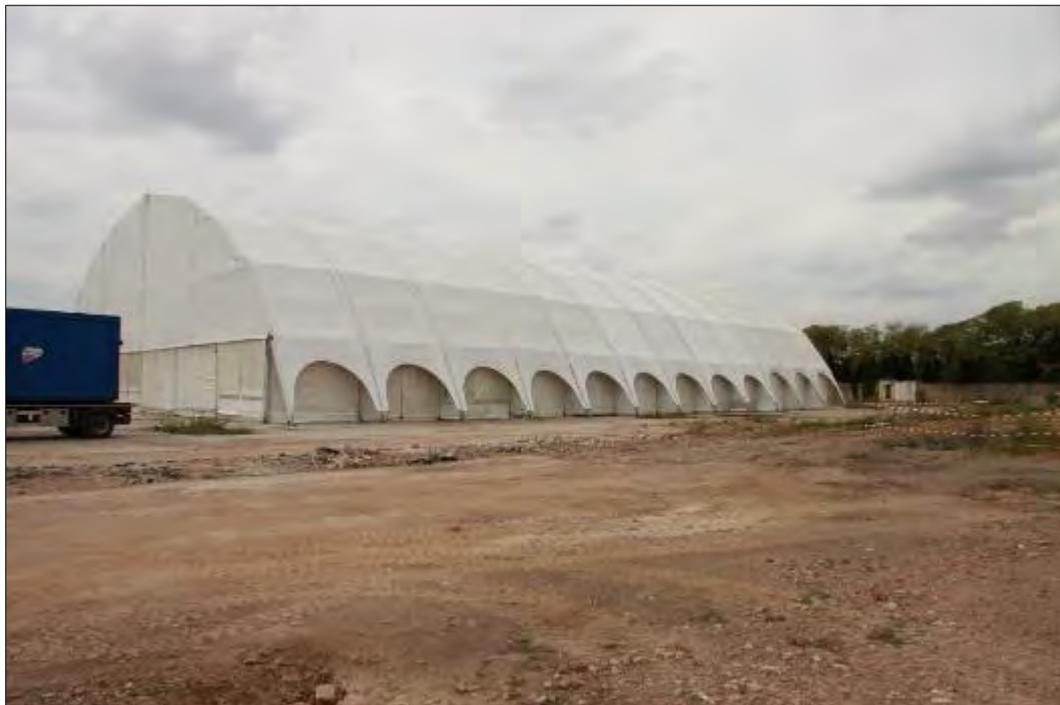
Foto 4: esempio 1 tensostruttura
